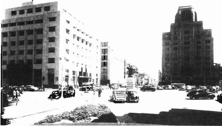
Transformación de la imagen urbana con la construcción de edificios modernos. AGN. Archivo fotográfico Díaz, Delgado y García, caja 86/16.
