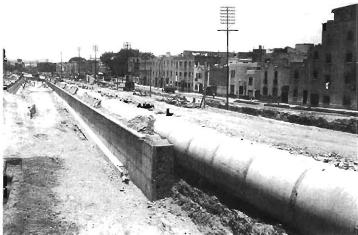
Entubamiento del río de la Piedad para construir el primer viaducto. Julio 26 de 1949. AGN. Archivo fotográfico Hermanos Mayo, Concentrados, sobre 658
