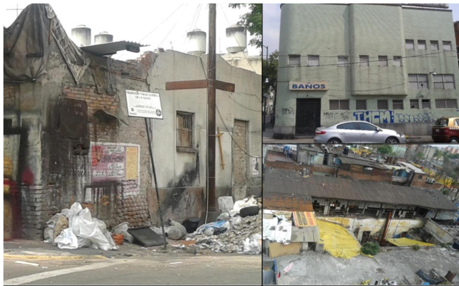
Imagen 1. Deterioro urbano-arquitectónico (recorridos 2014)
