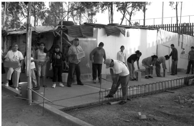
1. Proceso de autoconstrucción de vivienda en Iztapalapa, ciudad de México. Fuente: Archivo de la Asociación Renovación.
